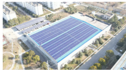
中鼎精工光伏项目（二期）
