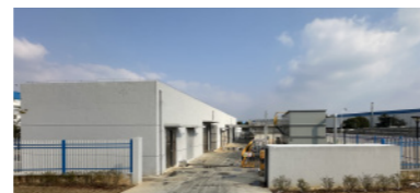
400T/D综合污水处理站
