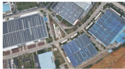
中鼎密封件南山园区光伏项目
