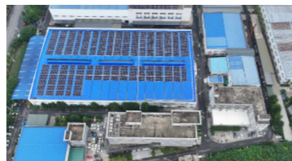
成都望锦光伏项目
