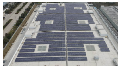
中鼎流体光伏项目（二期）
